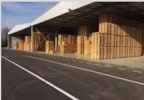
Dépôt logistique de Mâcon
